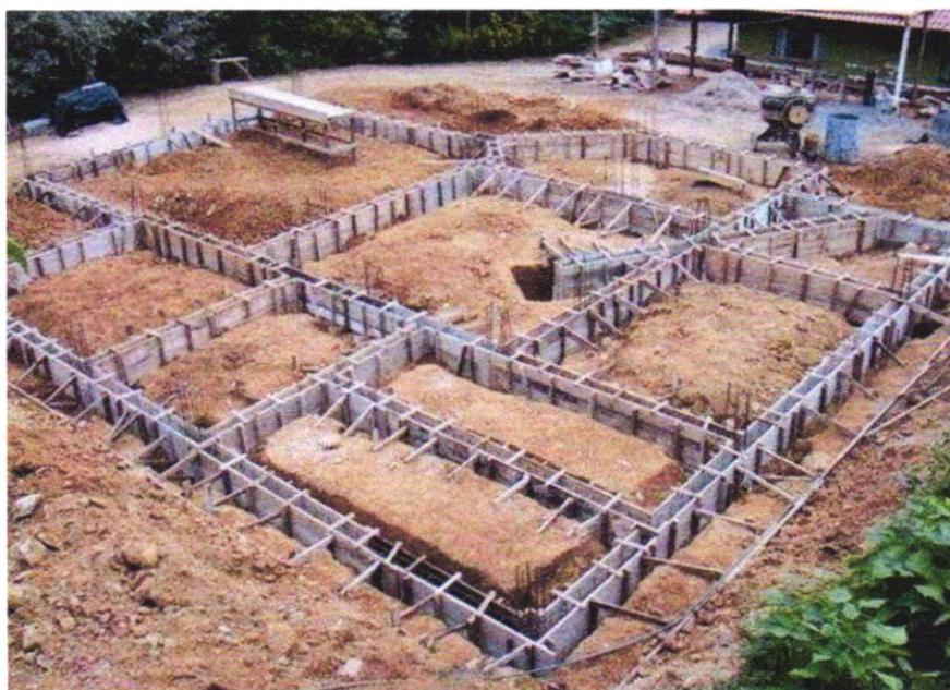
Deve ser feito o preparo do fundo (o serviço consiste na limpeza e regularização) após o preparo a área escavada deverá ser convenientemente apiloado e nivelado para receber uma camada de concreto não estrutural incluindo preparo e lançamento de concreto com para aplicação no fundo de valas, previamente preparadas, em uma camada de 3 cm como isolante para que a fundação não repouse diretamente sobre o solo.
