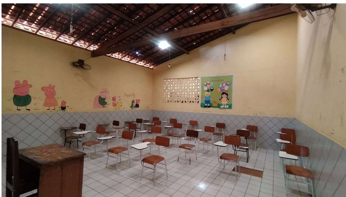
Salas com instalações elétricas expostas;
