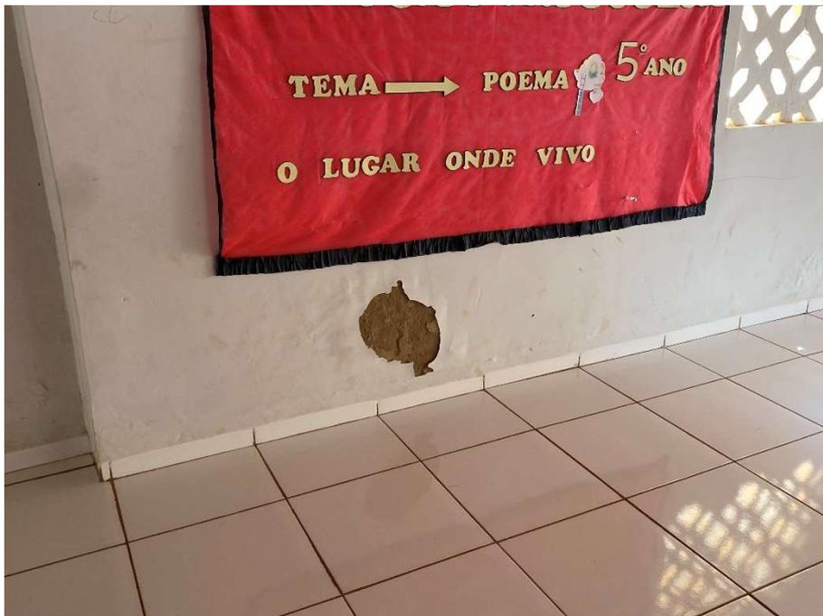
**Descamação de revestimento de parede;**
