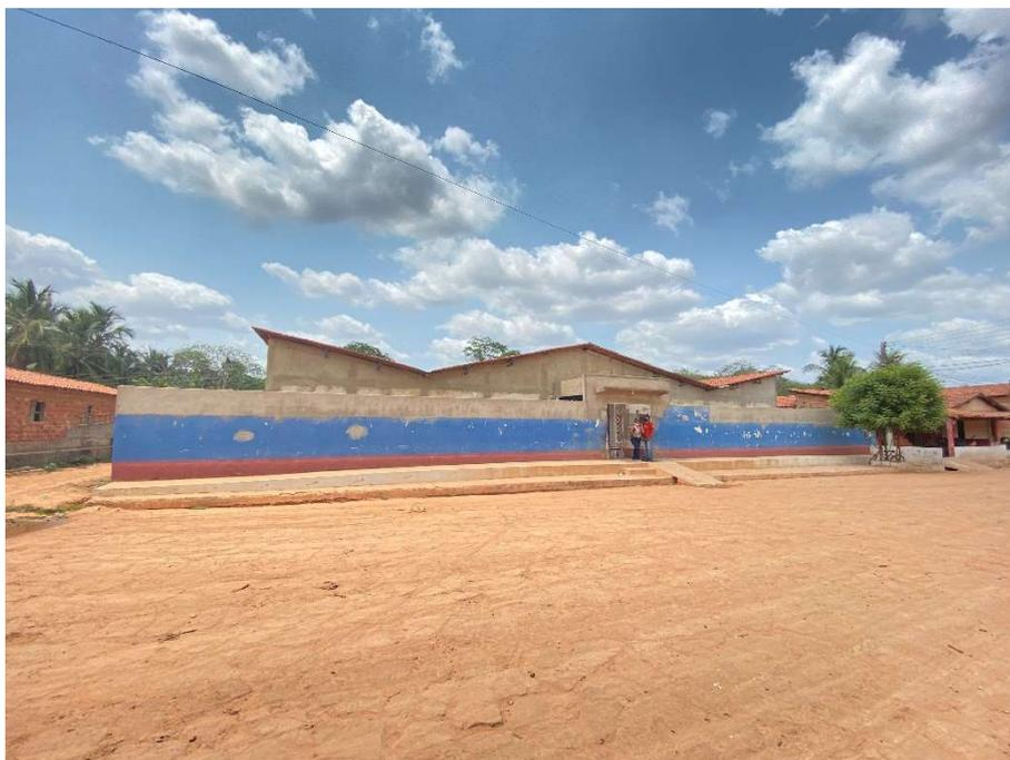
**Revestimento de fachada inacabado;**
