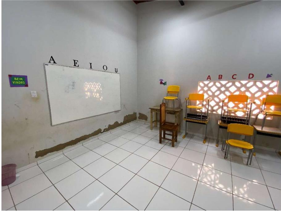
**Descamação de revestimento de parede;**
