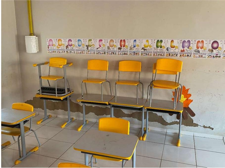
**Descamação de revestimento de parede;**
