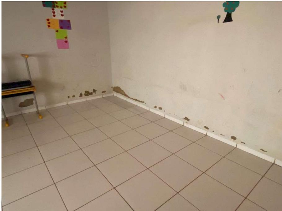
**Descamação de revestimento de parede;**
