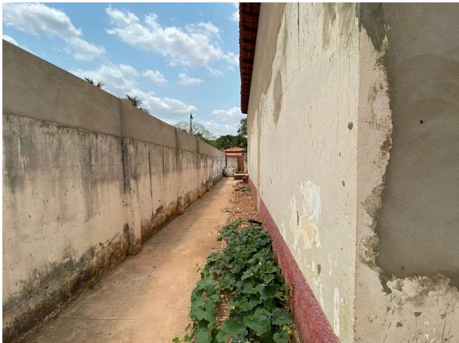
**Ausência de revestimento e calçada externa;**
