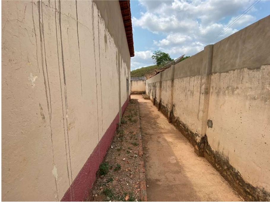
**Ausência de revestimento e calçada externa;**
