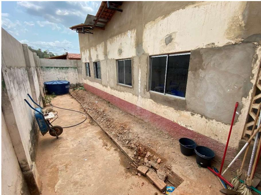
**Revestimento inacabado e ausência de calçada;**
