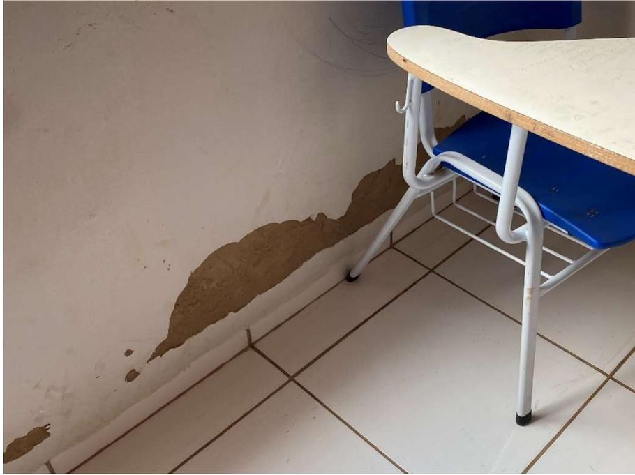
**Revestimento de parede arrancado/quebrado;**
