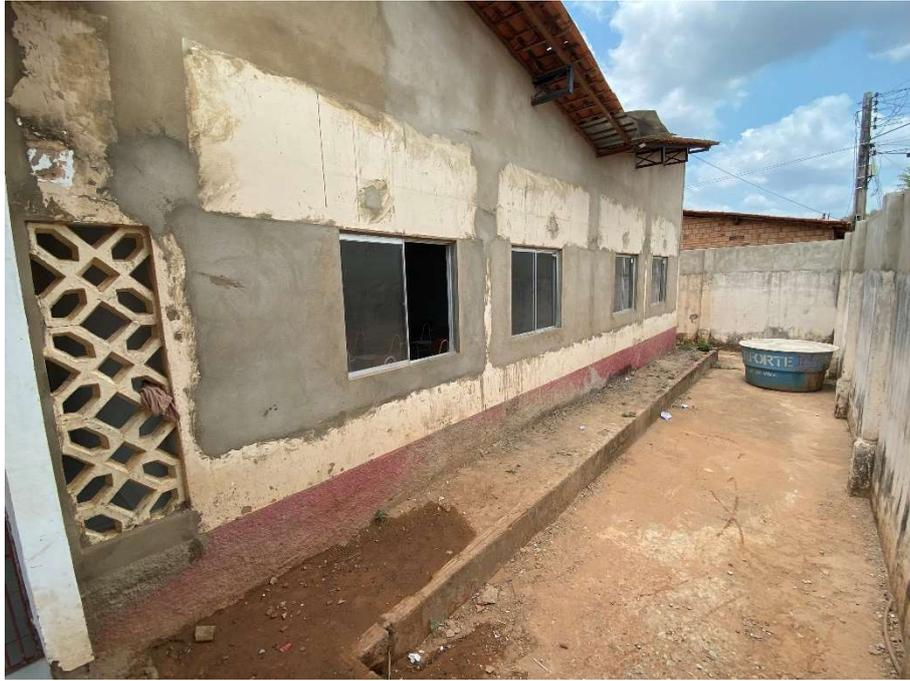
**Revestimento inacabado e ausência de calçada;**
