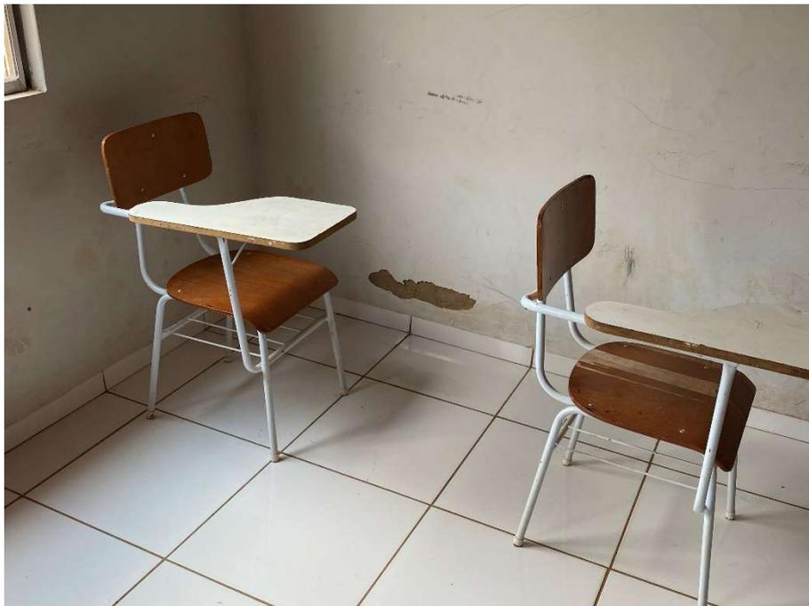
**Revestimento de parede arrancado/quebrado;**
