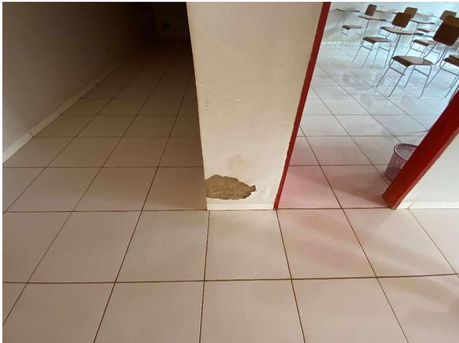
**Descamação de revestimento de parede;**
